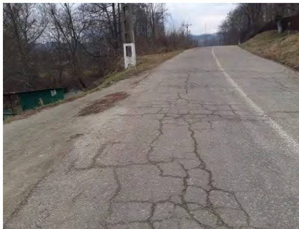
Degradări pe DJ 605C
